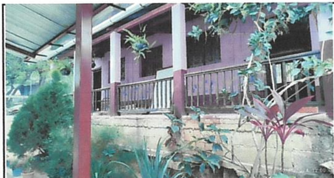
Mejoramiento de baranda en el corredor No.2
