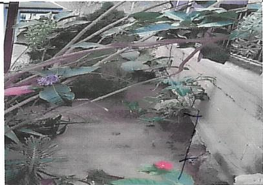
Elaboración de banqueta para evitar que se siga socabando el terreno y deje las columnas del corredor sin soporte de tierra.
