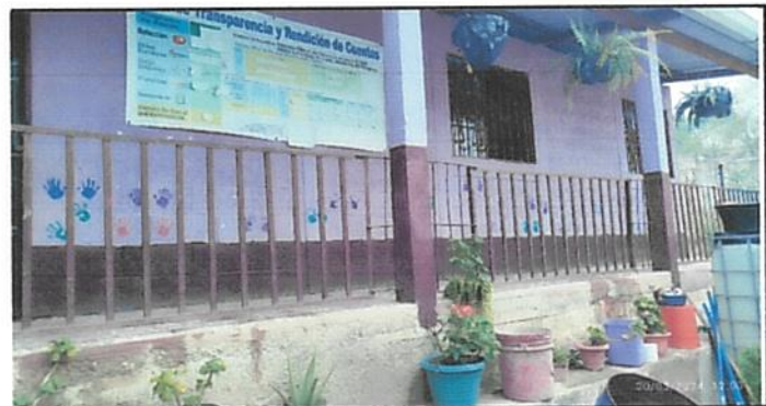
Mejoramiento de baranda en el corredor No.1
