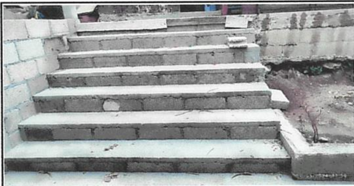
mejoramiento de gradas con colocacion de barandas
